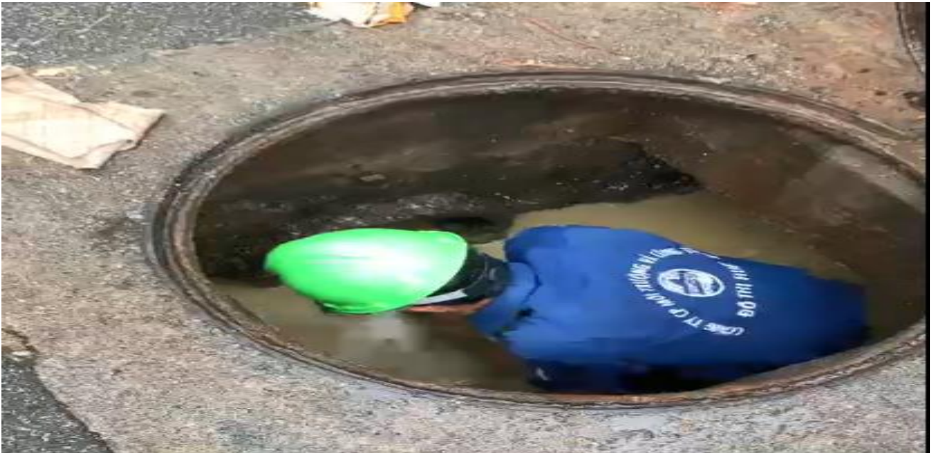
(Hình ảnh công nhân xử lý khơi thông, nạo vét lần 02 tại đường Phố Đức Chính ngày 25/10/2023)
