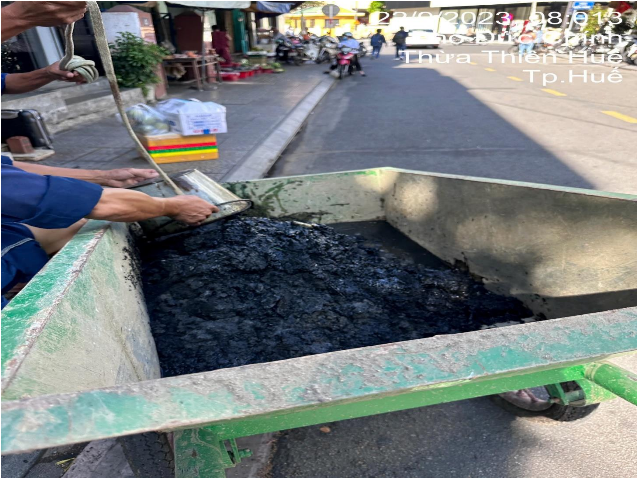
(Hình ảnh công nhân nạo vét hết hông thoát nước lần 01 tại đường Phó Đức Chính ngày 22/9/2023)
