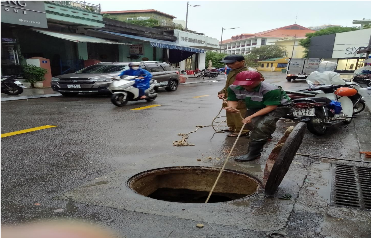
(Hình ảnh công nhân xử lý khơi thông, nạo vét lần 03 tại đường Phó Đức Chính ngày 14/11/2023)
